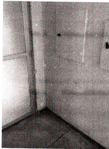
Foto 68 – Presença de umidade junto ao QD interno no corredor principal.
