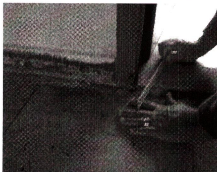
Foto 59 – Detalhe do recalque do piso do corredor interno ao lado das salas de trabalho.
