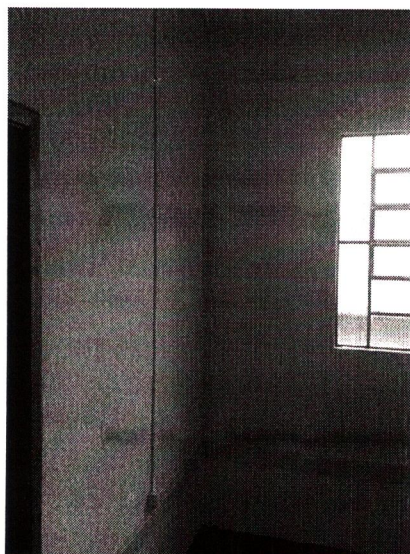
Foto 50 – Paredes umedecidas pela ação das águas pluviais.
