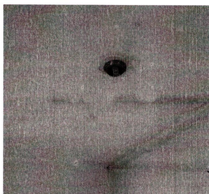
Foto 22 – Entrada de águas plu- viais pelas luminárias elétri- cas.
