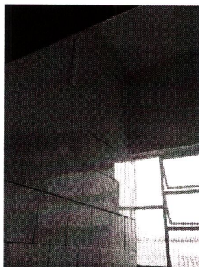
Foto 63 – Estufamento do revestimento cerâmico dos banheiros das salas de trabalho.
