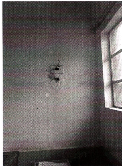
Foto 15 – Falta de chuveiro elétrico e presença de infiltrações nas paredes.
