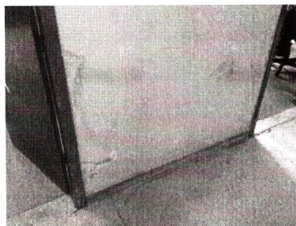
Foto 39 – Mancha de bolor nas paredes internas pelo excesso de umidade.
