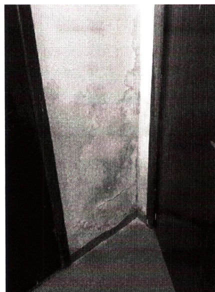
Foto 40 – Detalhe do ataque de fungos (mofo) nas salas internas pela umidade.
