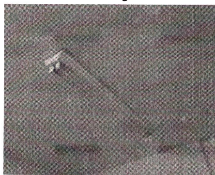
Foto 20 – Detalhe de luminária sem lâmpadas pela entrada de águas pluviais nas luminárias.
