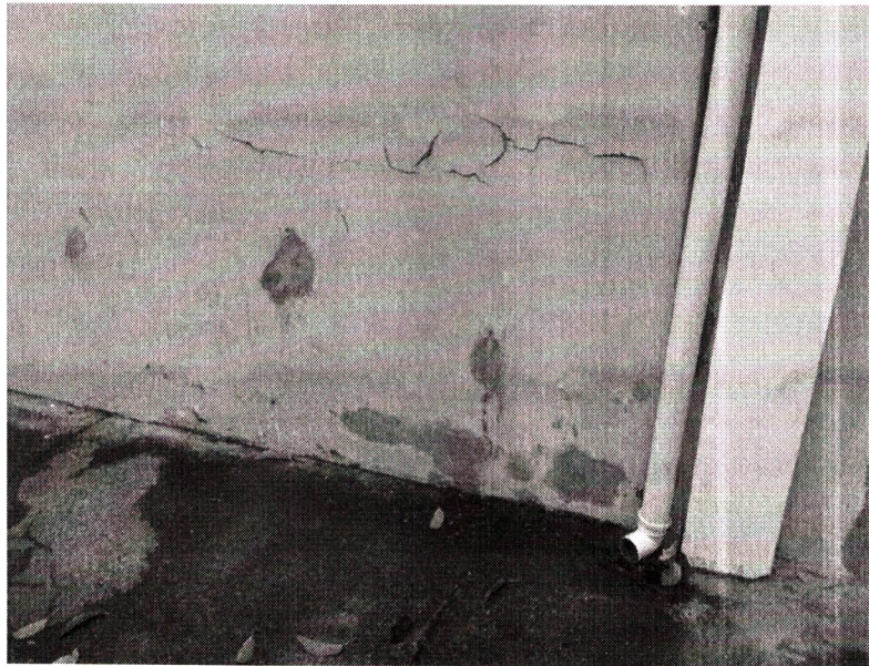
Foto 07 – Deterioração do reboco e pintura da fachada externa.
