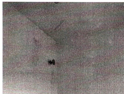
Foto 14 – Manchas de umidade pelo encharcamento da laje de cobertura.
