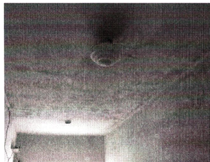
Foto 24 – Detalhe da umidade vindo do excesso de água sobre a laje de cobertura.
