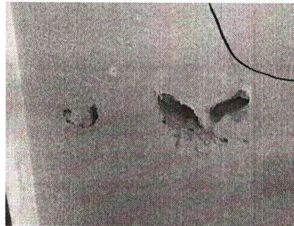
Foto 57 – Apodrecimento da alvenaria nas paredes laterais.
