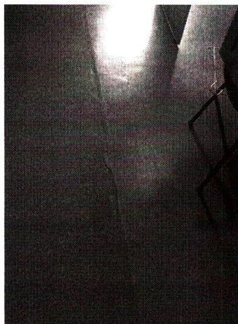
Foto 43 – Rachaduras e trincamento do piso de paviflex devido ao recalque da laje do piso.
