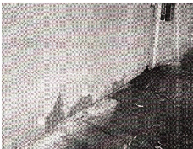
Foto 05 – Recuperação provisória do revestimento externo pela ação das águas pluviais.
