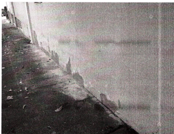
Foto 04 – Pintura deteriorada pela ação de umidade local.
