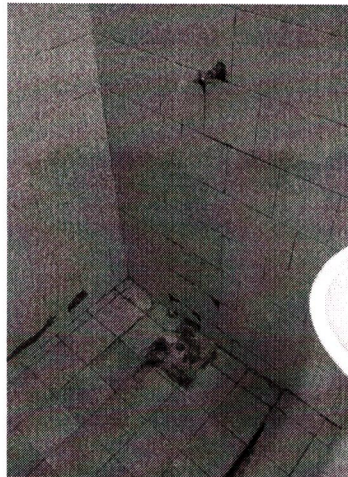
Foto 46 – Umidade atrás das cerâmicas nos Box dos chuveiros.
