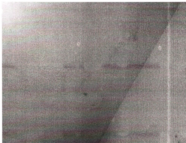
Foto 12 – Manchas de umidade e eflorescência da massa corrida na laje.
