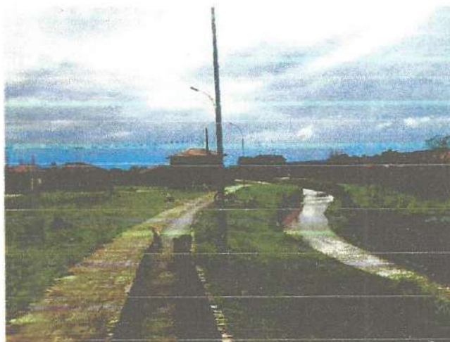
Figura 75 – Execução de obras de infraestrutura turística na Lapa- Paraná.
