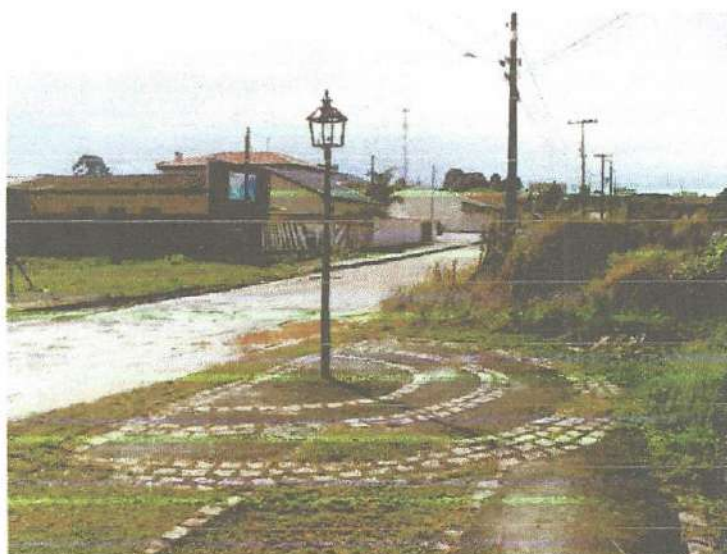
Figura 52 – Execução de obras de infraestrutura turística na Lapa- Paraná.
