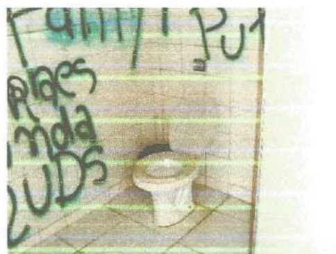
Figuras 105 a 108 – Execução de obras de infraestrutura turística na Lapa- Paraná. Visão geral do banheiro público. O interior apresenta revestimento cerâmico integral nas paredes e no piso. Há presença de vandalismo, mas também de uso (janelas com vidro quebrado).
