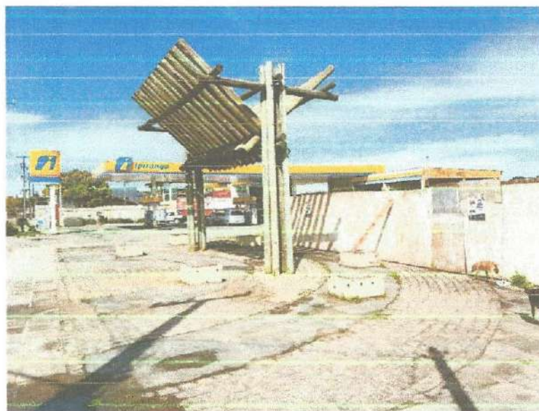
Figura 151 – Execução de obras de infraestrutura turística na Lapa- Paraná.
