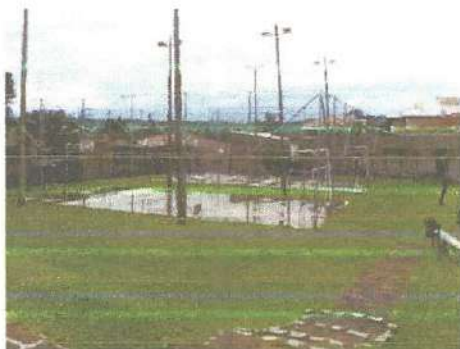
Figura 5 – Execução de obras de infraestrutura turística na Lapa- Paraná.
