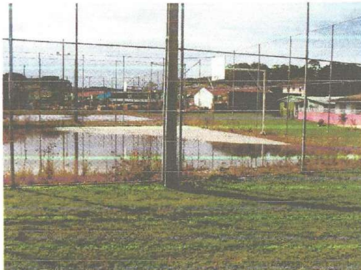
Figura 97 – Execução de obras de infraestrutura turística na Lapa- Paraná.
