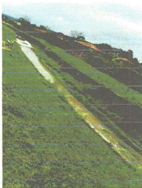
Figura 76 – Execução de obras de infraestrutura turística na Lapa- Paraná.
