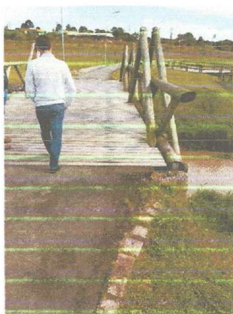
Figura 121 – Execução de obras de infraestrutura turística na Lapa-Paraná.
