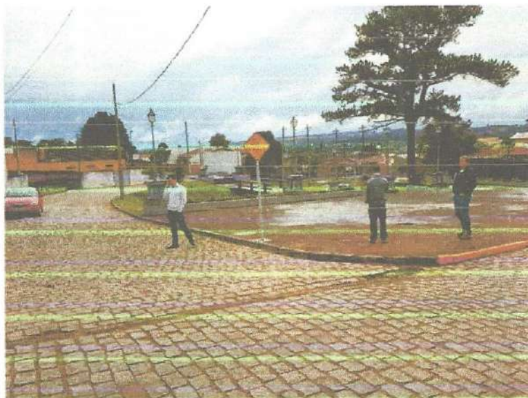
Figura 1 – Execução de obras de infraestrutura turística na Lapa- Paraná.
