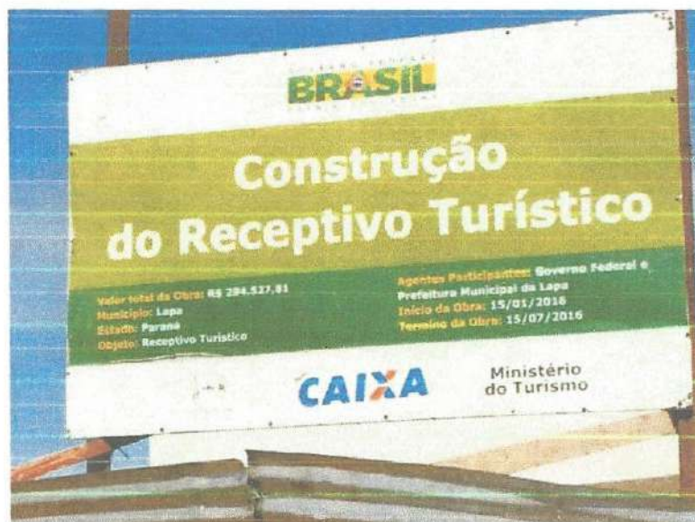
Figura 157 – Execução de obras de infraestrutura turística na Lapa- Paraná.
