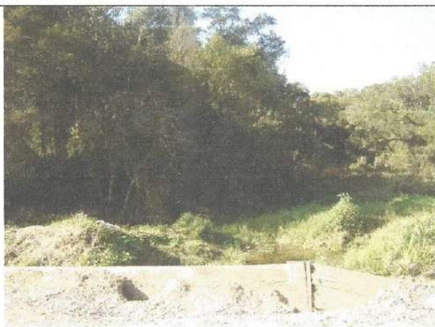
15. Córrego do Jardim Esplanada/Montreal Área alagada junto ao Bosque
