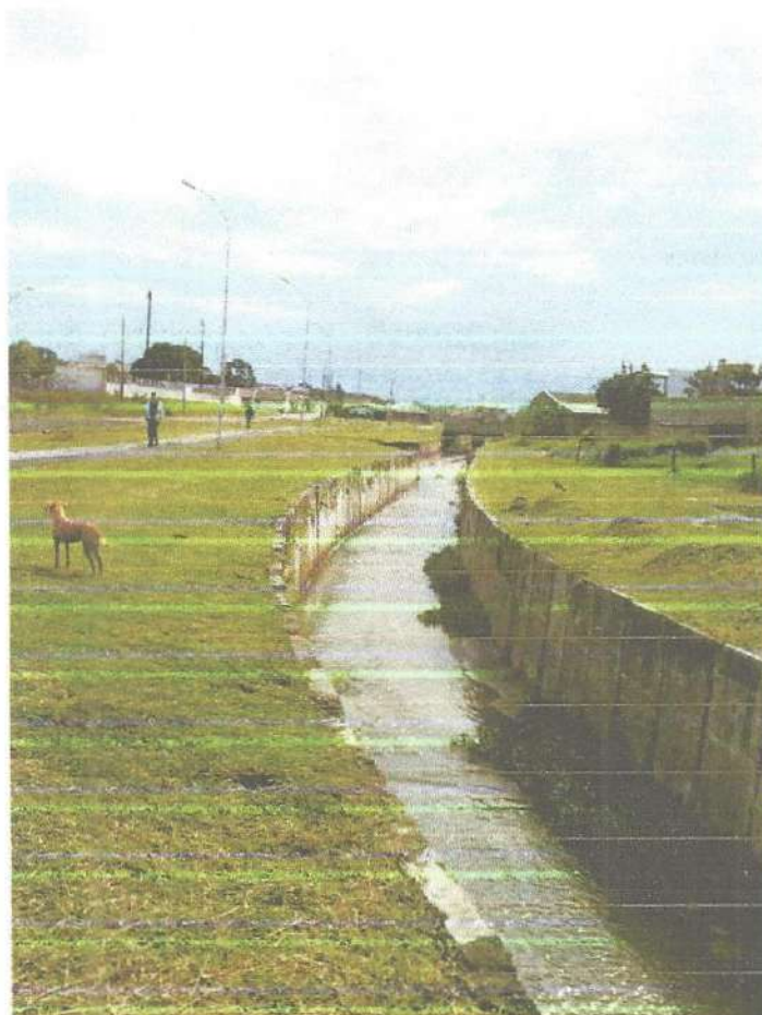
Figura 67 – Execução de obras de infraestrutura turística na Lapa- Paraná.
