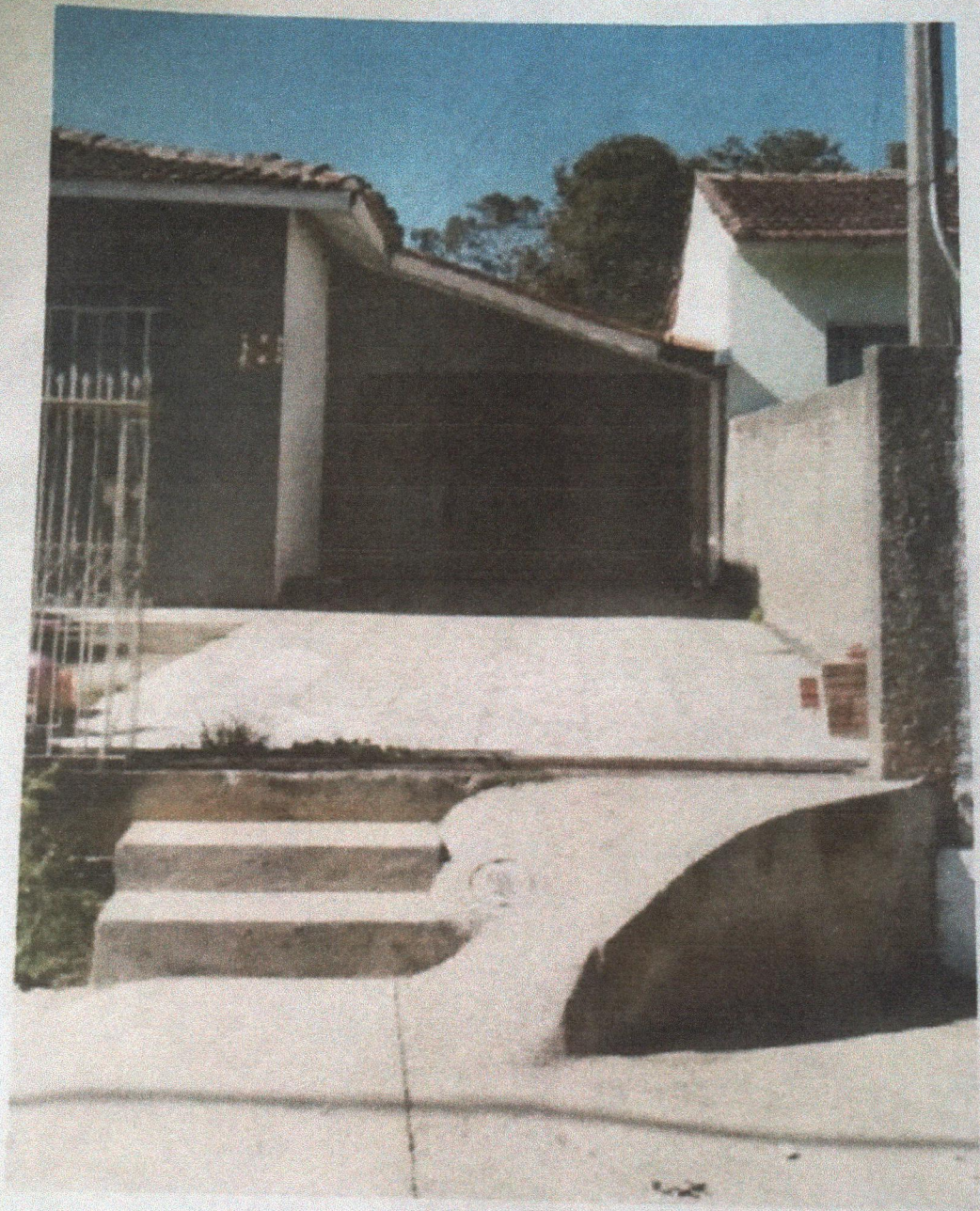
Após a pavimentação;
