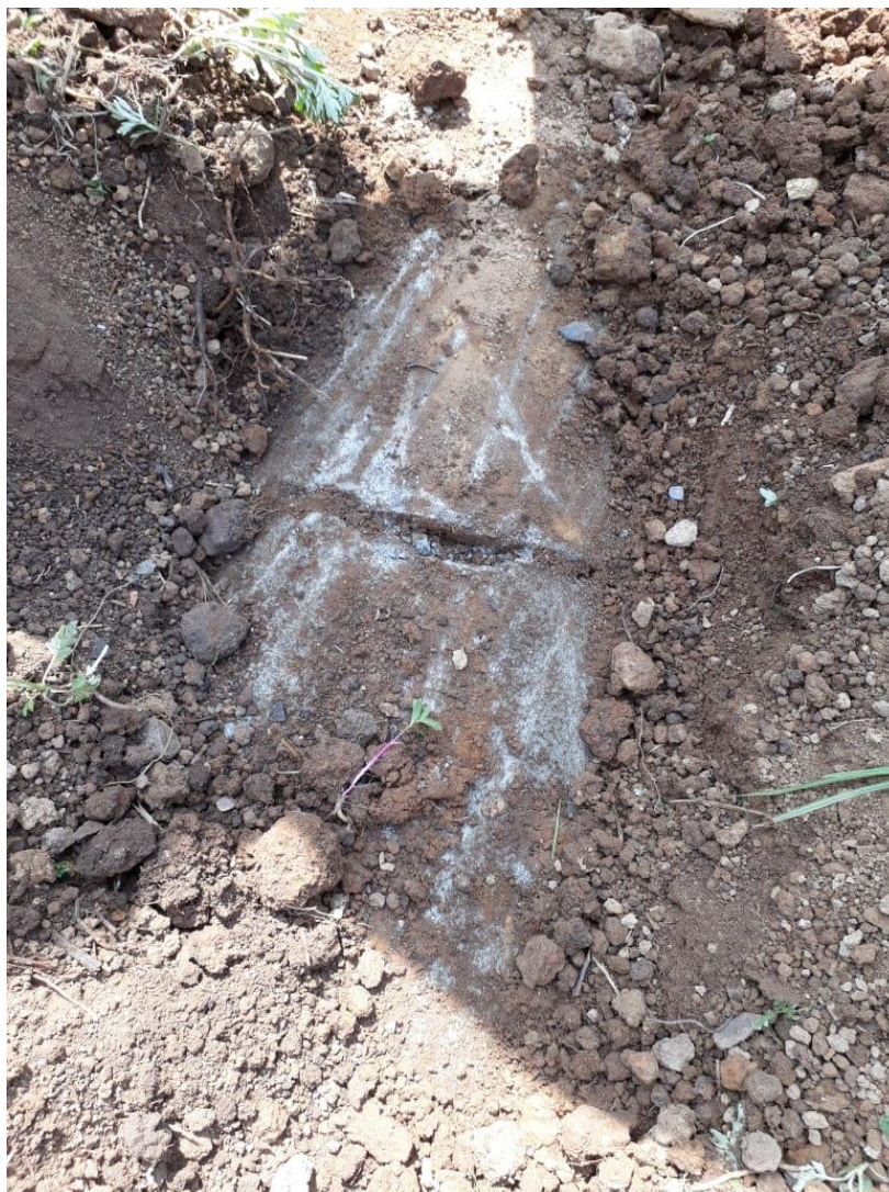
Foto 2 - Tubo assentado na Rua Serafim Ferreira de Almeida Maciel, detalhe para a junta não rejuntada.
