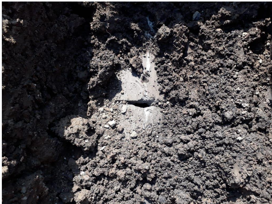
Foto 1 - Tubo assentado na Rua Professor Raimundo, detalhe para a junta não rejuntada.
