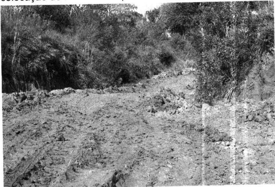
5. Em alguns pontos o lamaçal formado pela passagem de veículos pesados, estragou as valetas laterais para o escoamento das águas de chuva.
